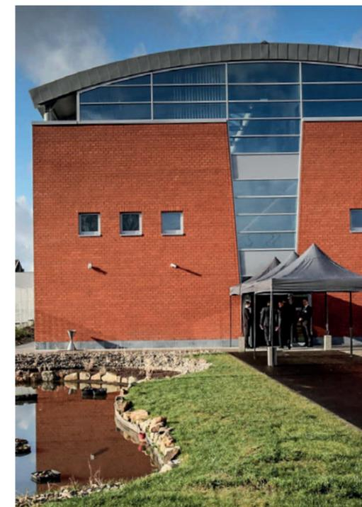
lui-ci est « basse énergie » : mesures pour réduire la consommation, luminaires à haut rendement ou LED, détection de présence, cellules photovoltaïques dans le lanterneau apportant une production locale d'électricité, pompe à chaleur, ventilation hygiénique, etc. Une zone de biodiversité a également été réalisée dans le but de créer un lieu de vie en milieu urbain, autour d'un point d'eau.
