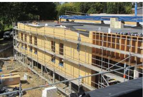
Le Campus de la Reid, grâce à sa structure bois qui permet un remplissage complet par de l'isolation, a un U de 0,11 W/m².k.
