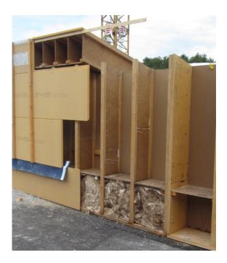
**Des toitures à versants** par de l'ouate de cellulose (constituée exclusivement de papier recyclé) insufflée sur une épaisseur de 40 cm dans la structure formée de caissons.
