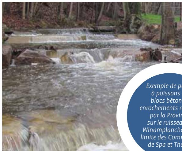
*Exemple de passe à poissons en blocs béton et enrochements réalisée par la Province sur le ruisseau le Winamplanche, à la limite des Communes de Spa et Theux.*
