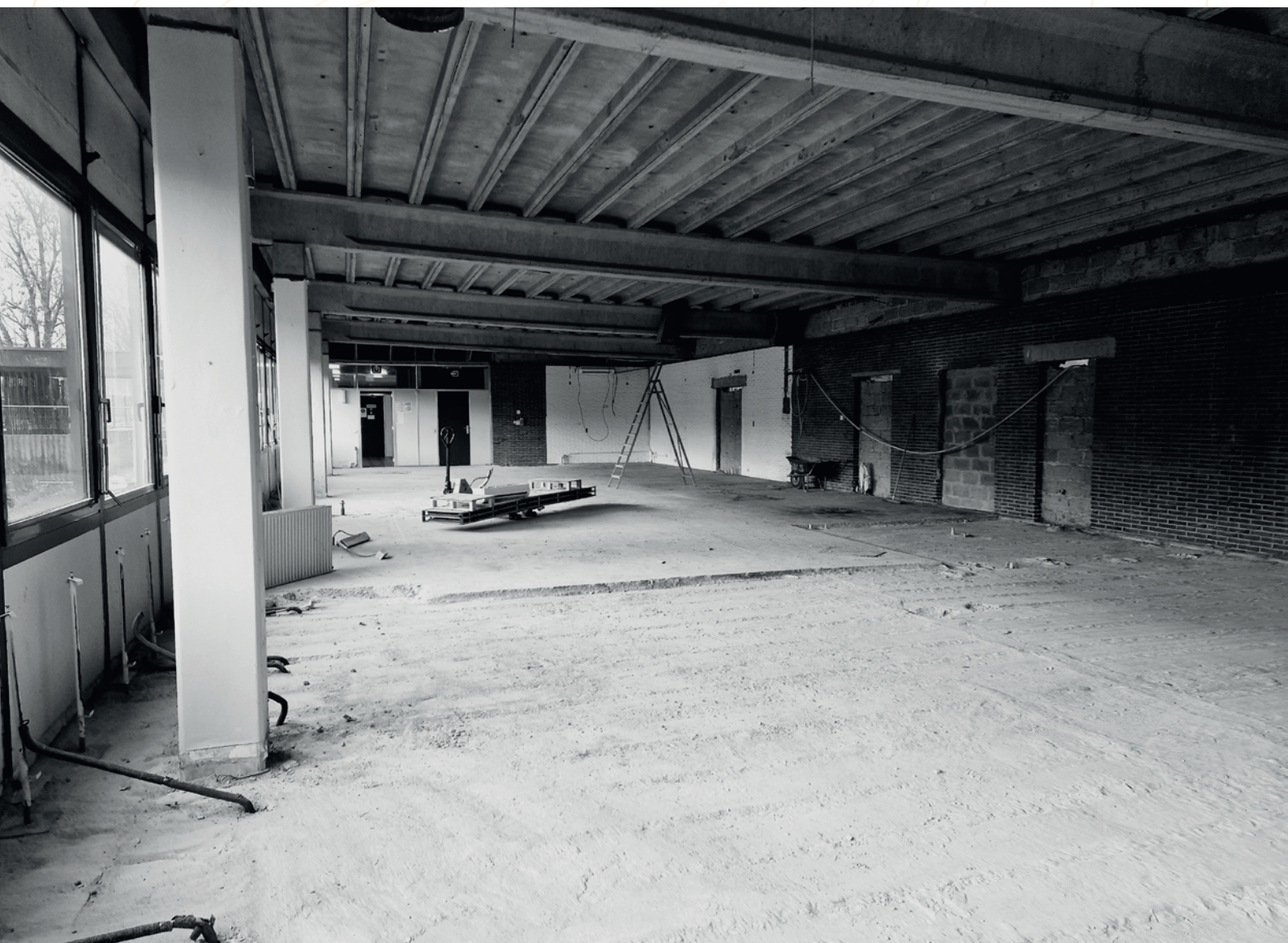
Travaux intérieurs CTL (début 2024)
