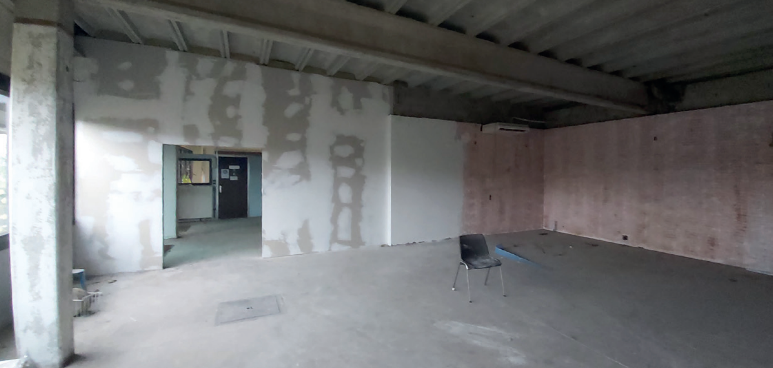
Travaux intérieurs CTL (fin 2024)
