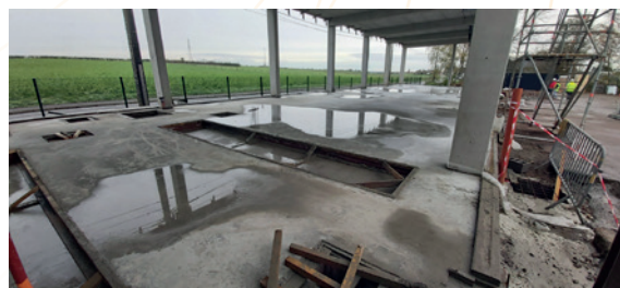
Travaux extérieurs CTL (fin 2024)
