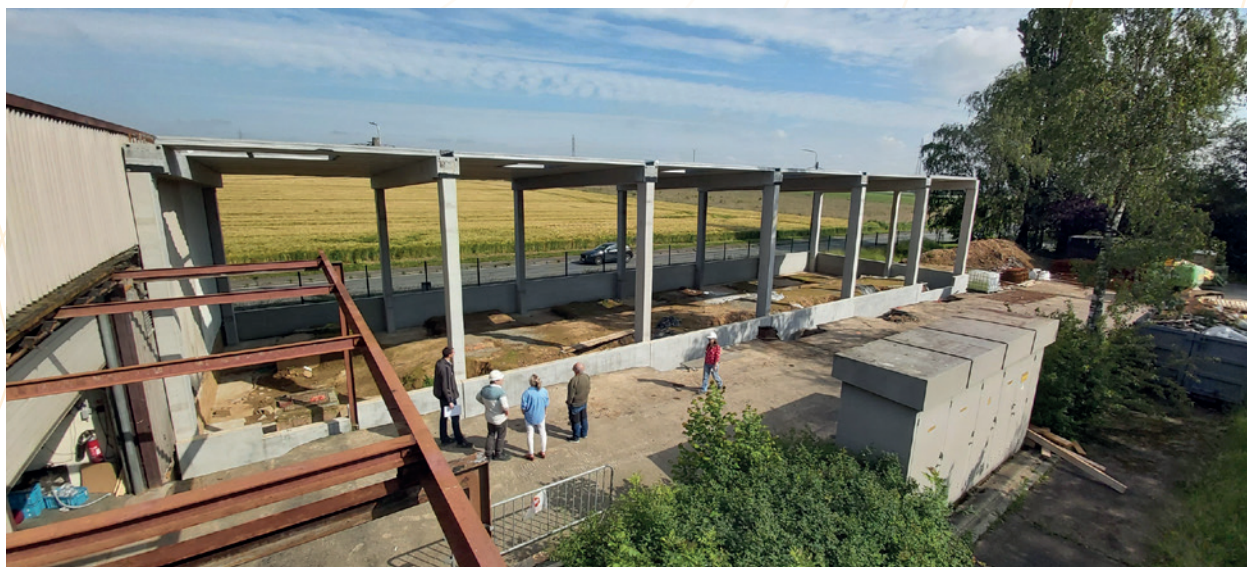
Travaux extérieurs CTL (fin 2024)
